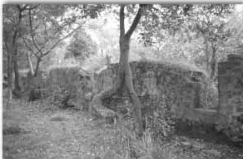
Fuerte de Ametzagaña, Batería de artillería. Son visibles las cajoneras abiertas en el parapeto, así como las banquetas, sobre las que se ha instalado vegetación.
