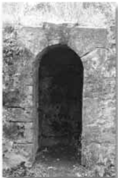
Fuerte de Ametzagaña. Acceso a la cajonera
