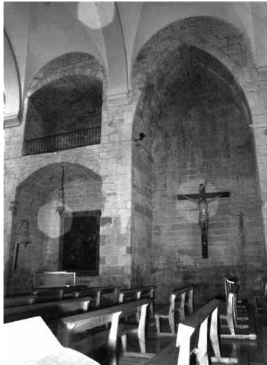
Arco apuntado del convento primitivo.
