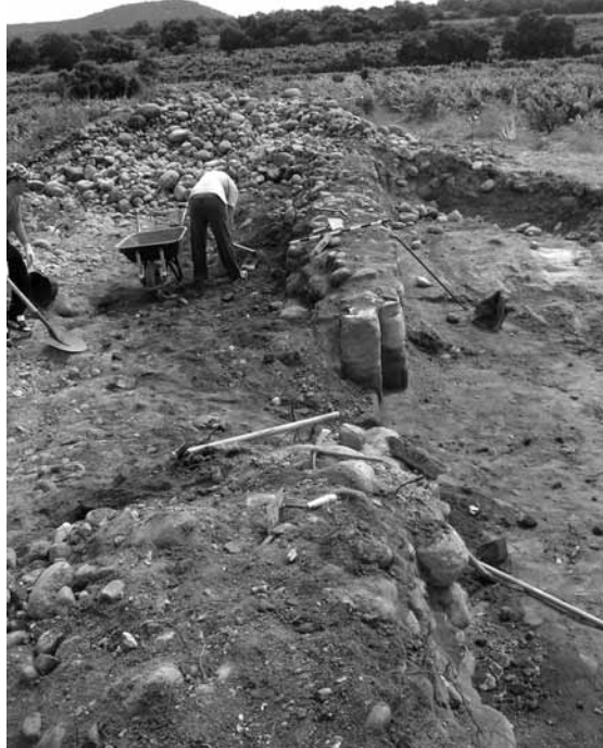
Detalle de los muros del edificio.
