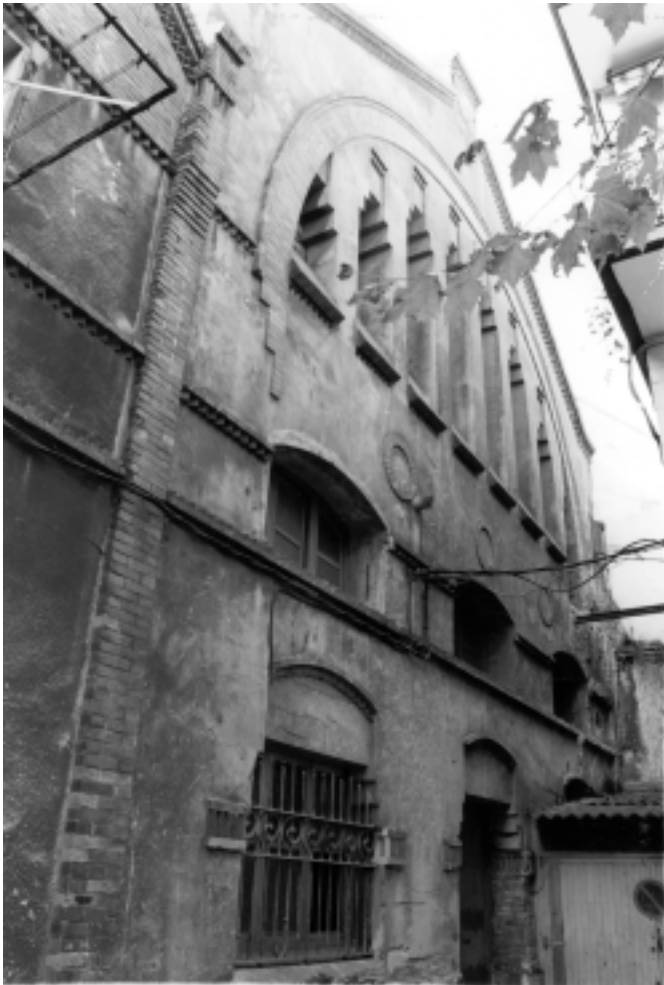
Edificio de la CAMPSA, antigua fábrica de Duelas Llusca (Buenavista)
